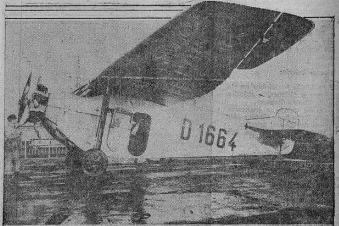
Este aeroplano ha causado gran interés en los círculos aeronáuticos de Alemania, pues se dice que no puede volcarse, por malo que esté el tiempo, debido a la especial construcción de las alas
